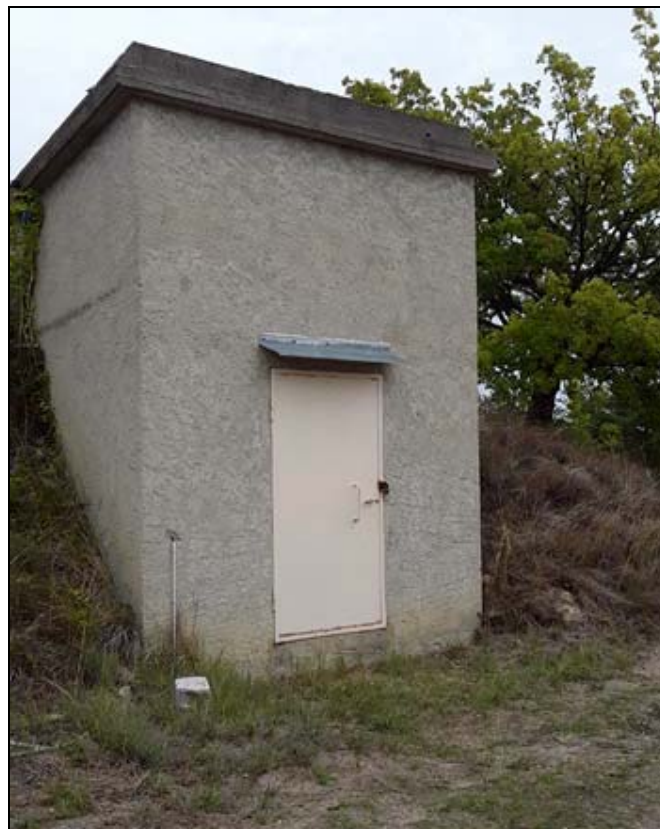
Château d'eau de 500m 3 en colline qui surplombe la campagne du Vivier.
